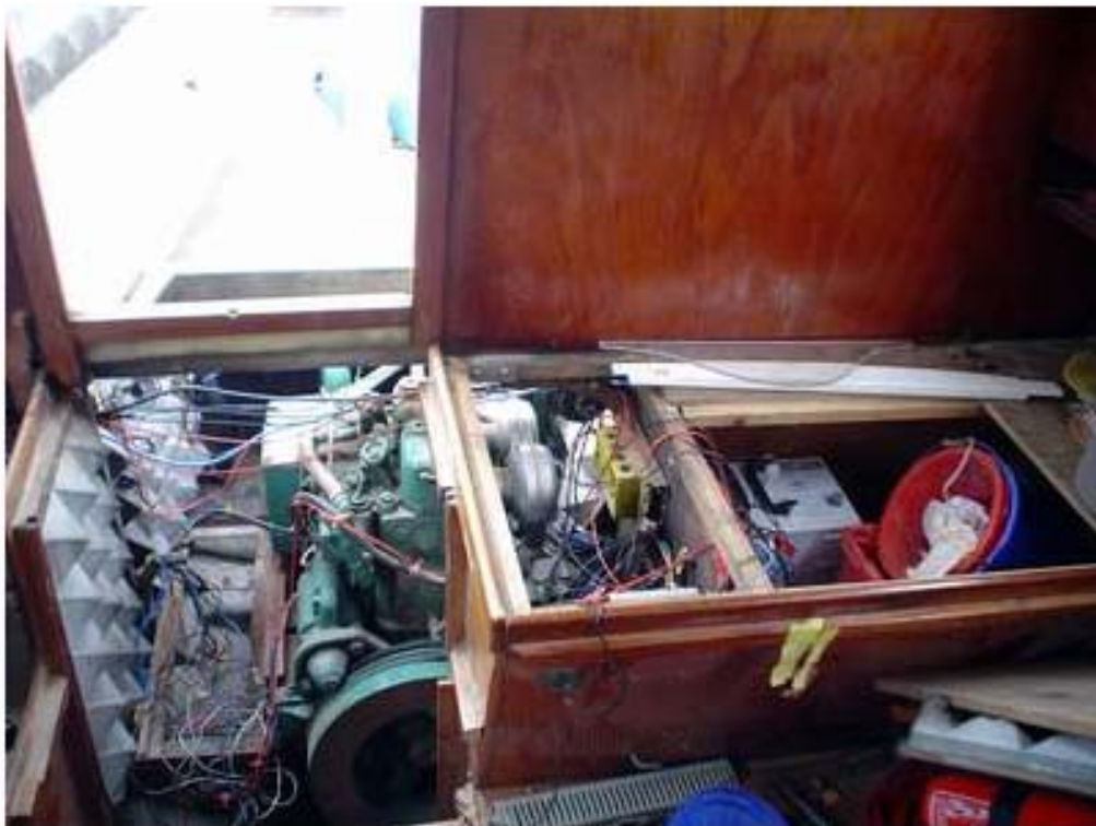
Die Motorverkabelung wird nur freigeschnitten, aber bleibt bestehen
